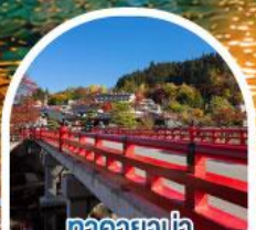
คิวควายาป่า สะพานนากะบาชิ
